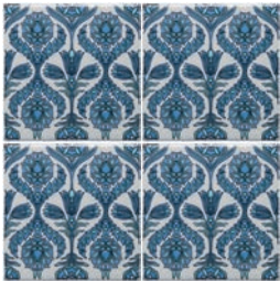
Richtig, da alle 4 Fliesen korrekt ausgerichtet sind
