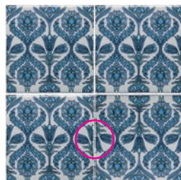
Неверно – узоры по бокам не сходятся, потому что плитка слева снизу находится в перевернутом положении
