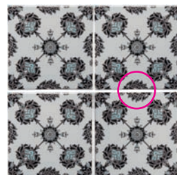
Cette disposition est incorrecte : les motifs ne sont pas alignés en haut et en bas car le carreau en bas à droite est mal orienté
